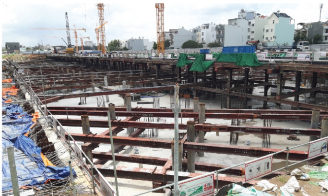
Dự án The Sun Avenue
